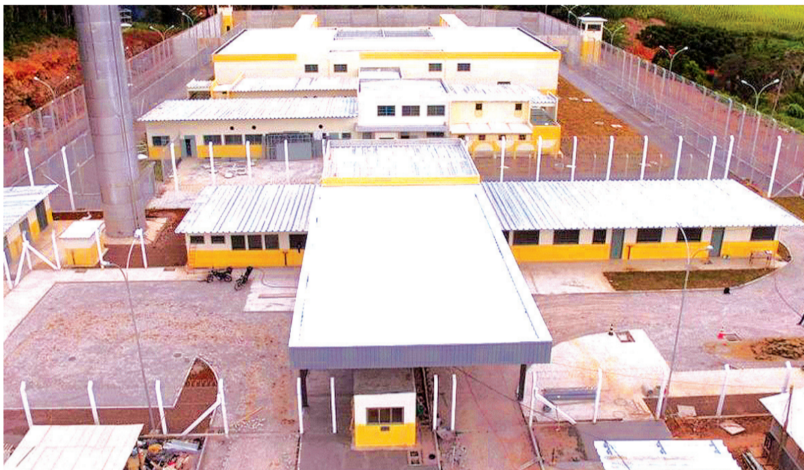
Mesmo com estrutura concluída desde abril segundo informações da Susepe, e com a garantia do vice-governador para inauguração em abril, a penitenciária ainda não tem data prevista de inauguração
