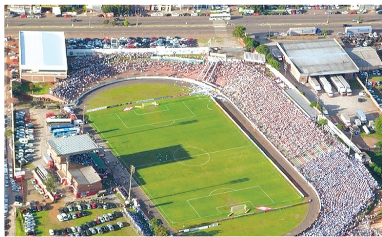
Estádio Vermelhão da Serra
