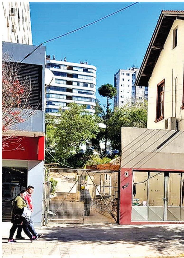
Obra foi interditada por falta de documentação
