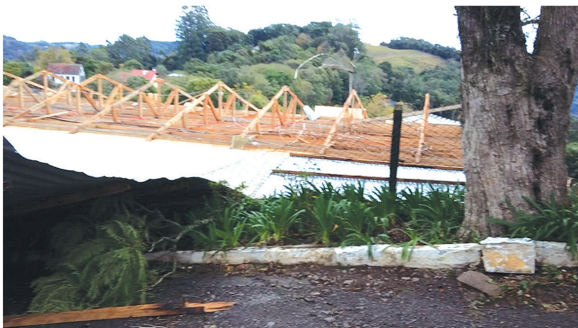
Teto da Escola Estadual Ângelo Chiamorela, em Faria Lemos, desabou
