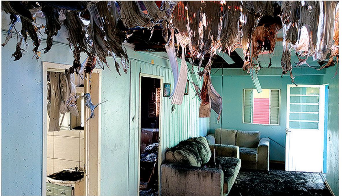
Pedreiro vai reformar teto, piso e trocar janelas e portas atingidas pelas chamas
